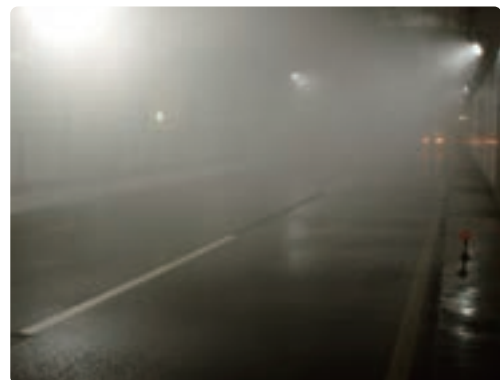
【水噴霧放水中】
