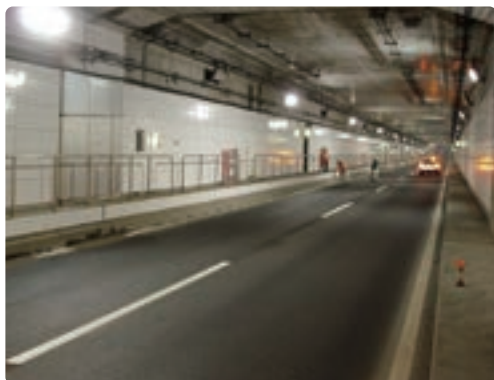
【水噴霧放水前】
