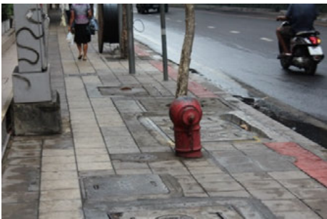
歩道上の消火栓
