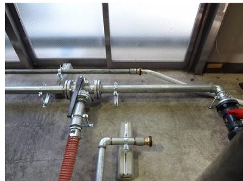
泡水溶液-水の切替用三方弁
